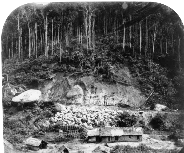
21. À beira da ferrovia de Campinas, ainda em construção, um caboclo ergue a sua casa. (Foto de Nicklesen, 1880)
